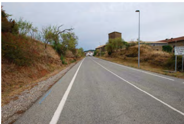
Inicio del acondicionamiento de la Travesía PK. 010
