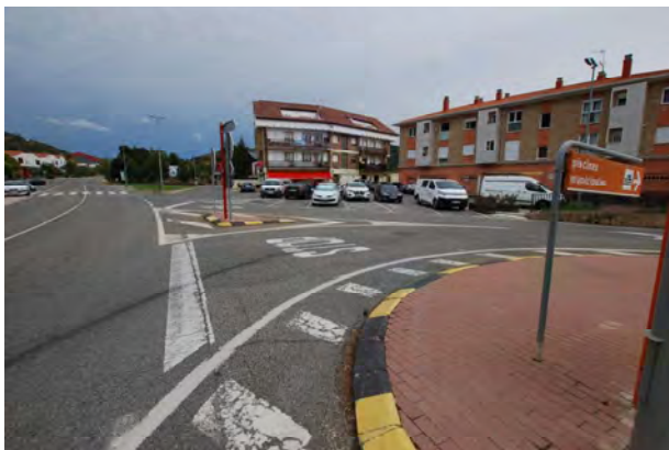
Isletas existentes en la intersección PK. 310
