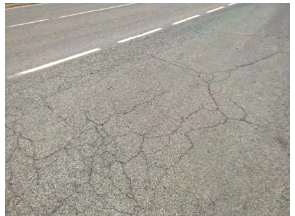
Fisuras en el pavimento
