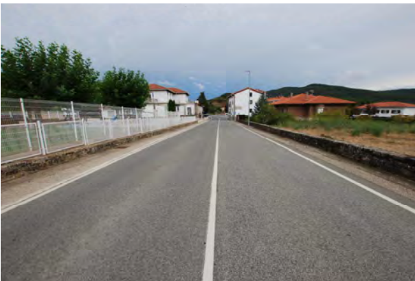
Muretes en ambos lados. Zona con acera derecha sobreelevada PK. 220
