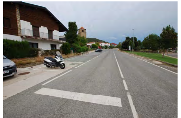
Zona de ensanchamiento lado izquierdo PK. 350
