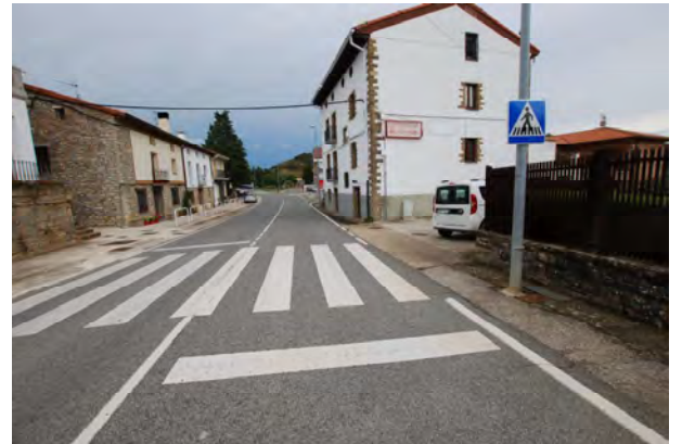
Lado derecho casi sin acera. Zona frente al edificio del Ayuntamiento PK. 260
