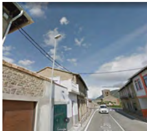
Líneas aéreas entre edificios de la travesía
