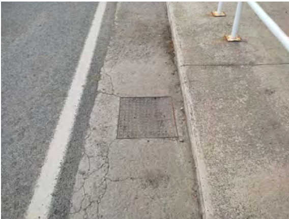
Rejillas de pluviales cegadas
