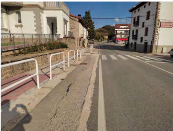
Se observa franja blanca de canalización de NASERTIC
