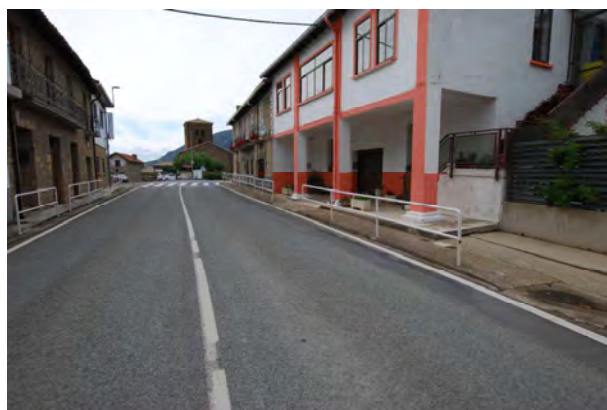
Zona estrecha. Vista sentido inverso PK. 180
