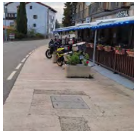
Arqueta telefónica junto al hostel Arangoiti
