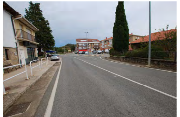
Estado de la desviación a Javier PK. 290
