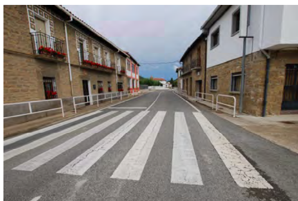
Zona estrecha PK. 140
