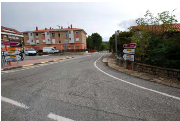
Carretera a Javier NA-5410 PK. 300
