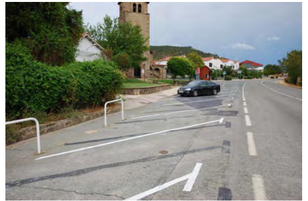
Zona de aparcamiento en batería PK. 370
