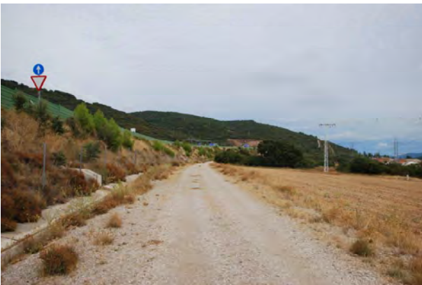
Camino de servicio de la A21
