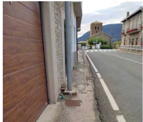
Farola en zona de acera y entrada a cota inferior a cota de la calzada
